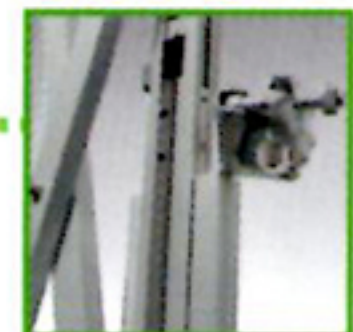
門柱単管への固定
